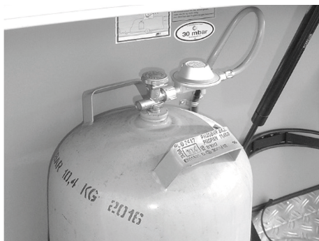
Bild 71: Gasolflaska med lågtrycksregulator och lågtrycksslang
