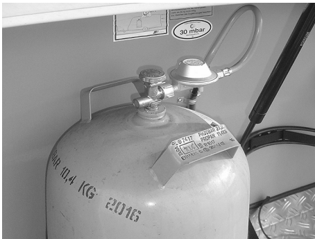
Bild 104: Gasolflaska med tryckreducerventil
