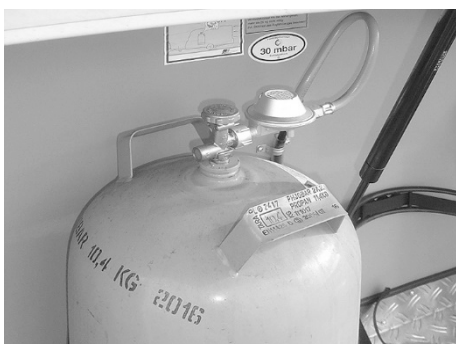
Fig. 107 : Bouteille de gaz avec détendeur
