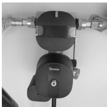
Fig. 83 : Alimentation en gaz (avec Eis-Ex et téléaffichage)
