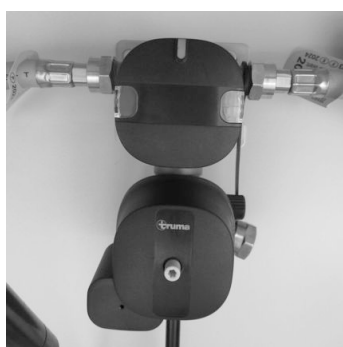
Fig. 109 : Alimentation en gaz DuoControl CS
