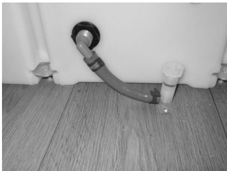
Fig. 93 : Exemple de vanne de vidange
