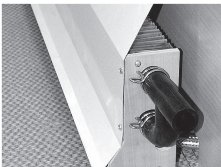
Bild 91: Konvektor med värmeledningsplåt
