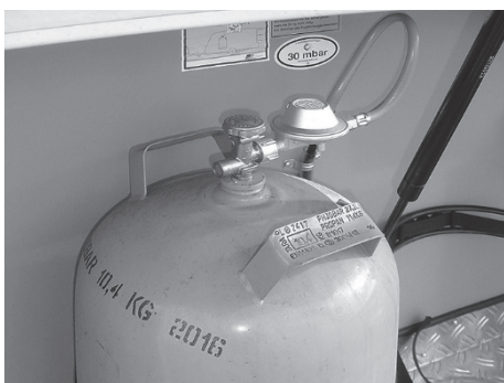
Bild 115: Gasolflaska med tryckreducerventil
