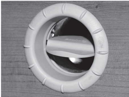
Bild 83: Varmluftspjäll, öppet
